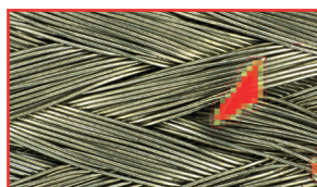
Inspection de câblage, cordes
